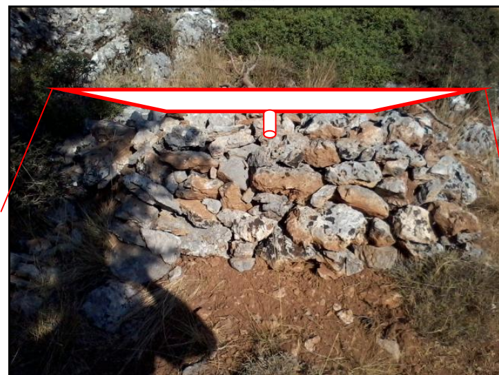
Δεξαμενή αποθήκευσης νερού 250 lt.. Με κόκκινη διαγράμμιση το σχέδιο του ομβροσυλλέκτη.
